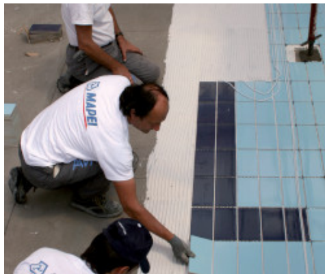
Kerámia burkolólapok fektetése Mapelastic Zero -ra úszómedencében
