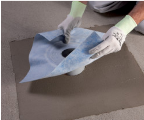
Drain Vertical elhelyezése Mapelastic Zero -n
