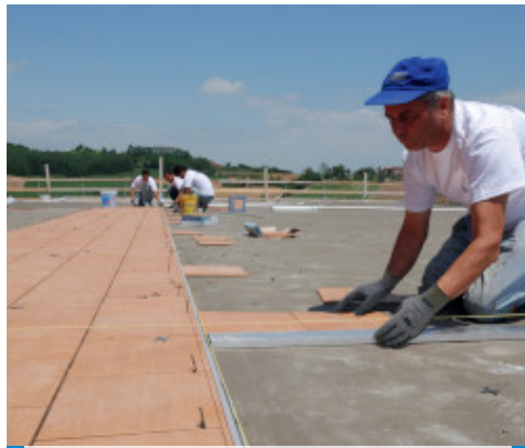
Kerámia burkolat fektetése Kerabond + Isolastic -kal
