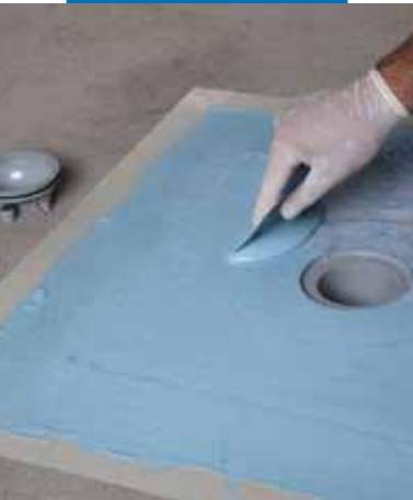
Drain Vertical impregnálása Mapelastic® AquaDefense-vel
