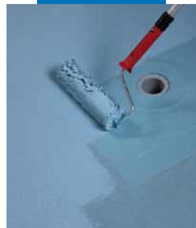
A Mapelastic® AquaDefense második rétegének felhordása hengerrel
