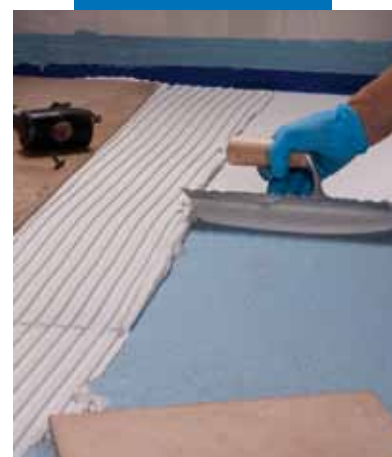
Burkolólapok ragasztása Mapelastic® AquaDefense-re
