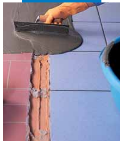
Meglévő padlóburkolat simítása Adesilex P4-gyel
