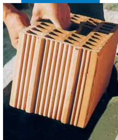
Falazóblokk mártása Adesilex P4-be
