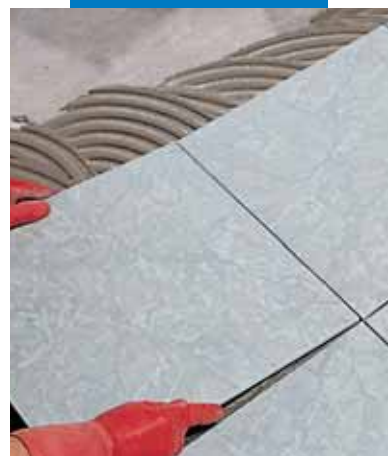
Porcelán burkolólapok fektetése
