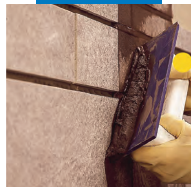
Ultracolor Plus felhordása falra gumisímitóval
