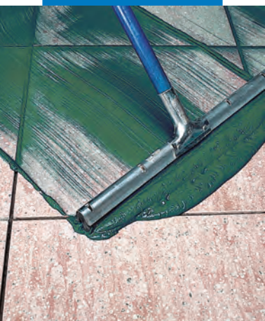
Ultracolor Plus felhordása padlón gumilehúzóval
