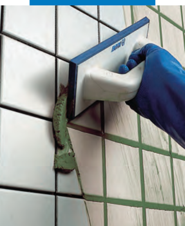
Ultracolor Plus felhordása falra gumisímitóval
