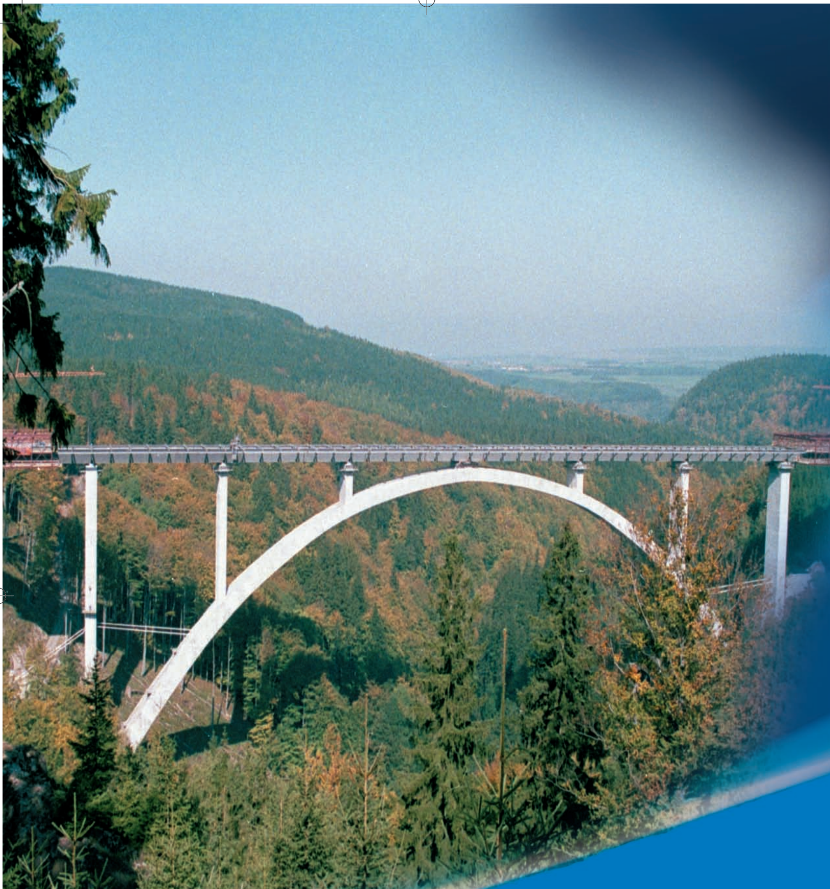
WILDE GERA HÍD - Németország Felhasznált termékek: DYNAMON SX, MAPETARD
