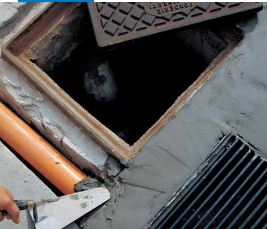
Csővek és aknafedő elhelyezése Lampocem-mel
