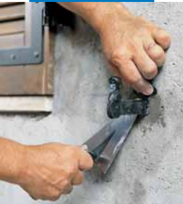
Ablak horgonycsavarjának rögzítése Lampocem-mel
