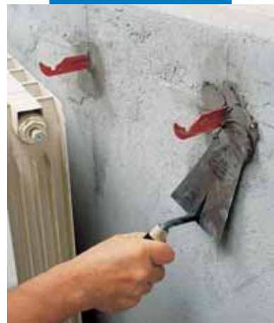
Radiátor konzoljainak rögzítése Lampocem-mel
