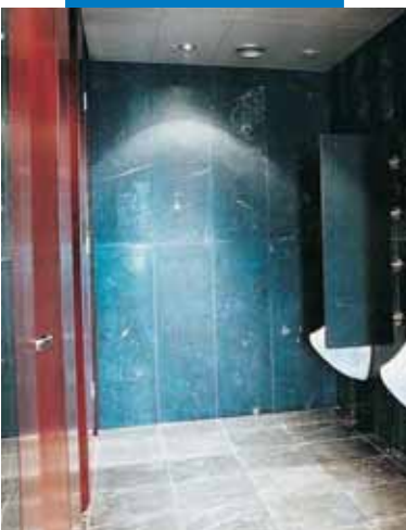
Példa Keraquick-el ragasztott márvány falburkolatra a Feuchtwangeni kaszinó mosdójában (Németország)
