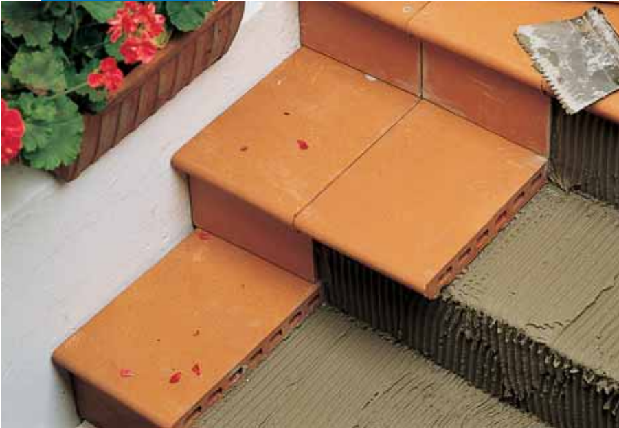
Lépcsőlapok gyors ragasztása
