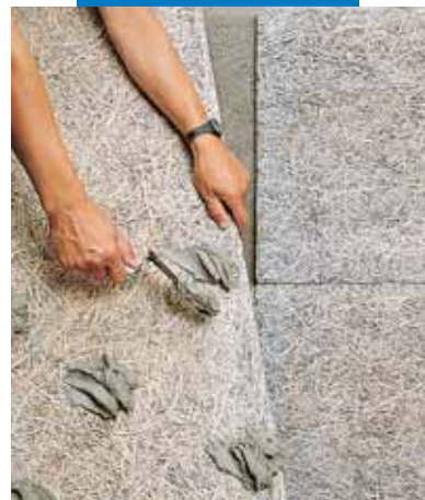
Nehéz szigetelőtáblák ragasztása
