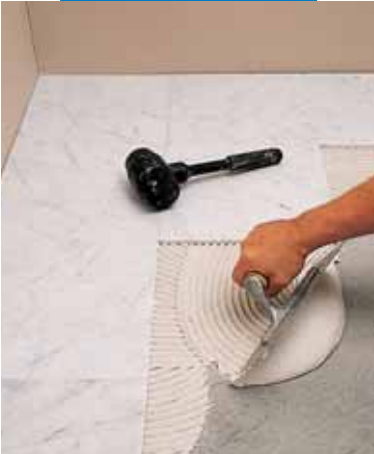
Fehér Carrarai márvány fektetése fehér Keraquick-kel
