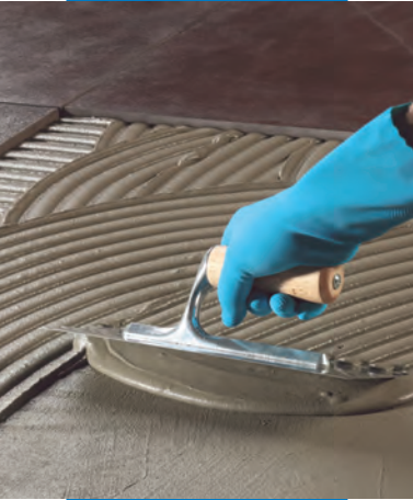
Keraflex Easy felhordása az aljzatra félköríves fogazású simítóval
